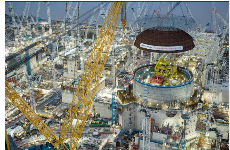
Chantier des EPR d'Hinkley Point C (Royaume-Uni)
